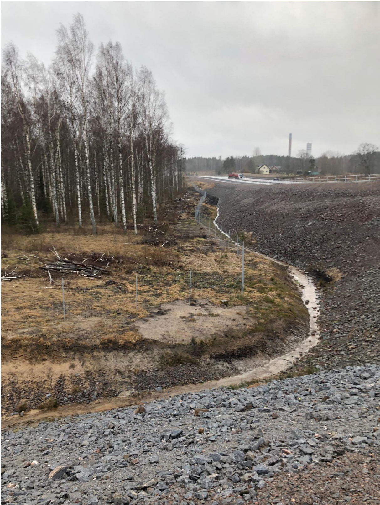
Dike längs västra fastighetsgränsen.
